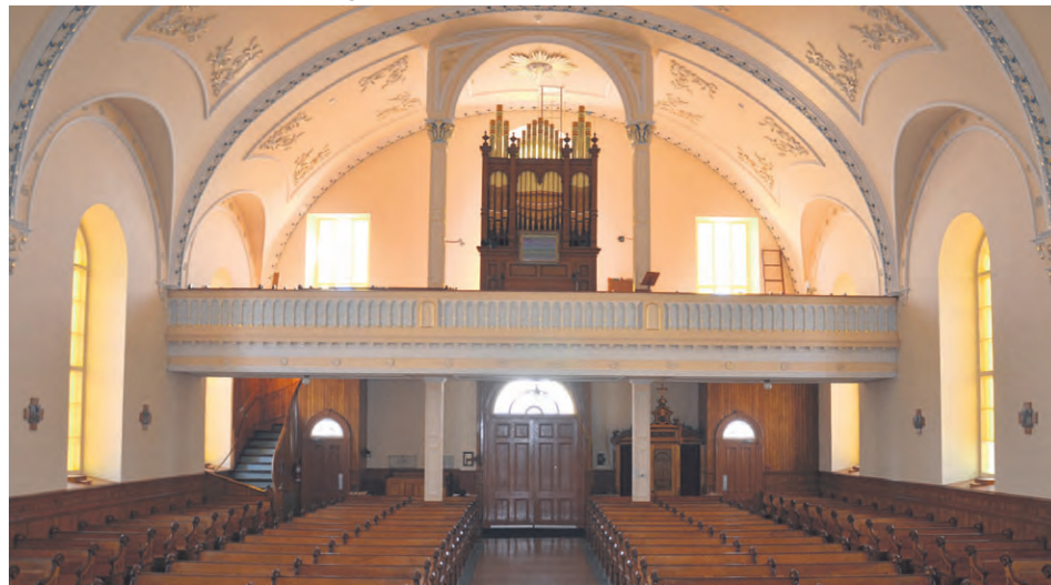
Le mur d'escalade serait aménagé sur la paroi du balcon de l'église. Photo : Maxime Paradis
