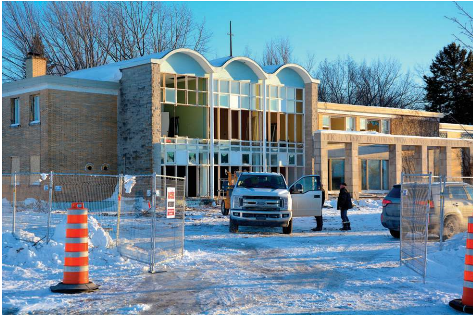
La Villa Saint-Jean est en cours de démolition à La Pocatière. Photo : Maxime Paradis.
