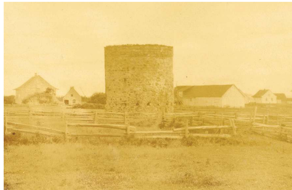
Le moulin de Saint-Denis avant sa démolition en 1919. Crédit : Archives de la Côte-du-Sud et du collège de Sainte-Anne.
