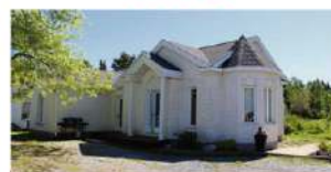
SAINT-ROCH-DES-AULNAIES 131, rue Ancil 163 500 $
