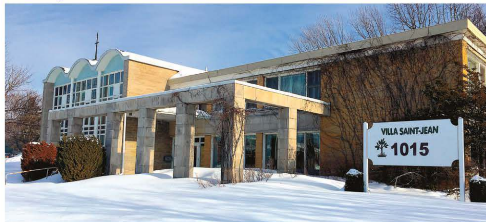
La Villa Saint-Jean serait sur le point d'être vendue et démolie. Photo : Maxime Paradis.
