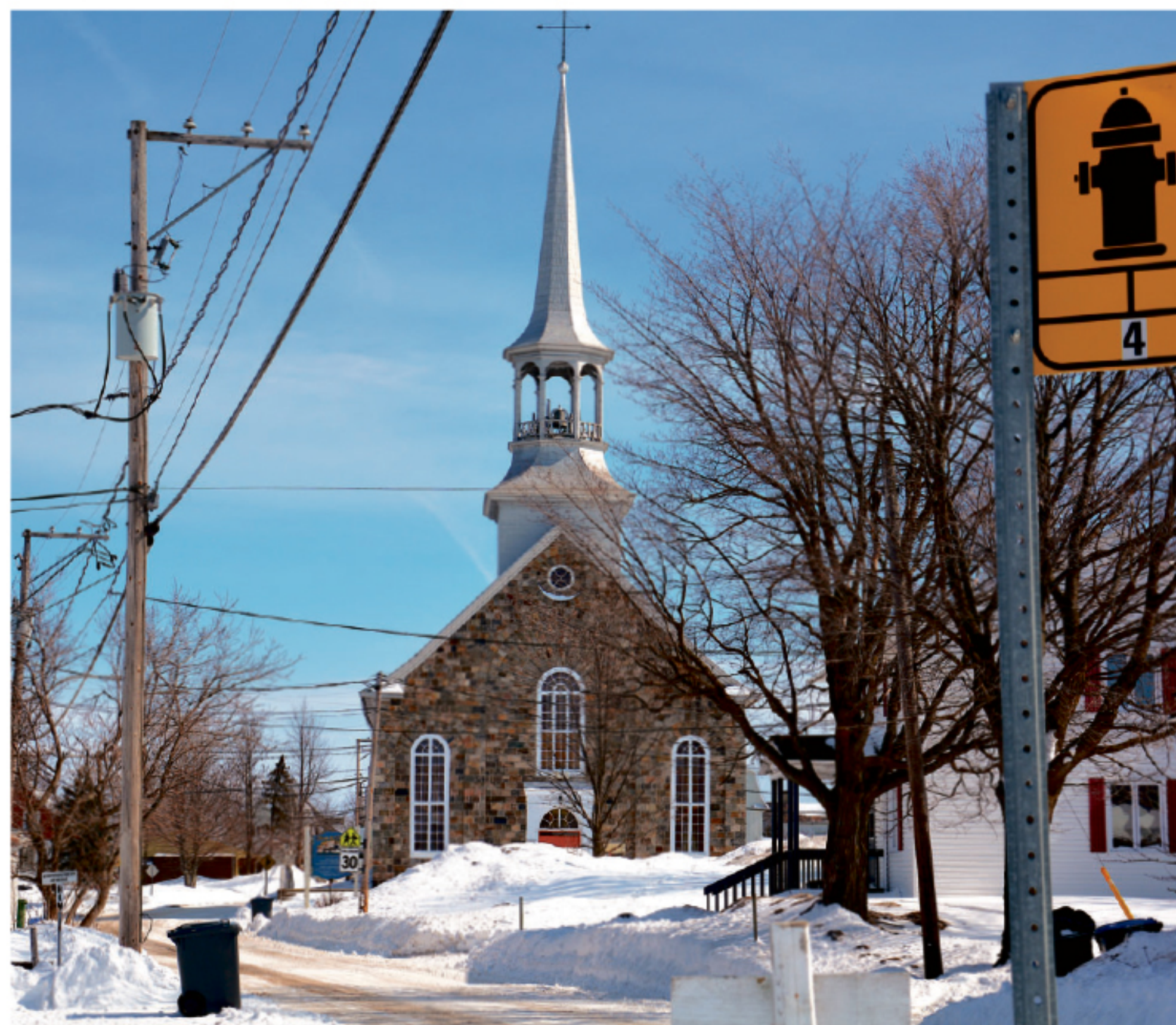
Le prolongement du réseau d'aqueduc s'annonce salé pour 19 résidents de Sainte-Louise. Photo : Maxime Paradis.
