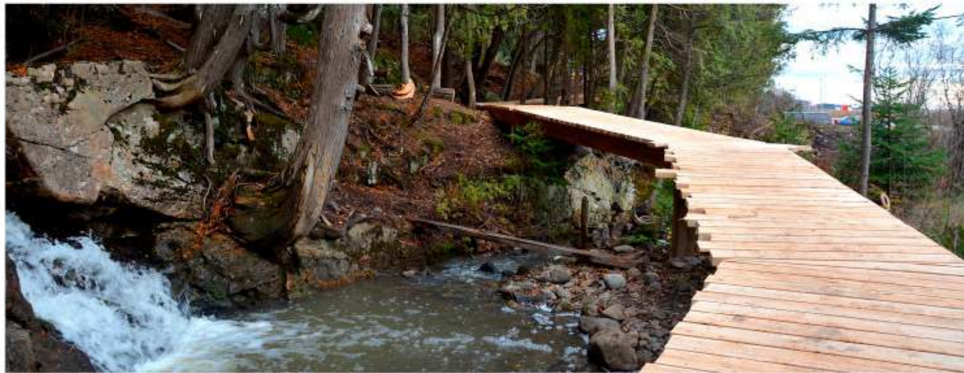
Cette passerelle doit permettre de lier le stationnement et la billetterie à l'amphithéâtre. Photo : Maxime Paradis.
