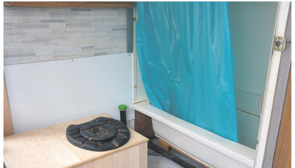
Toilette compost et douche.
