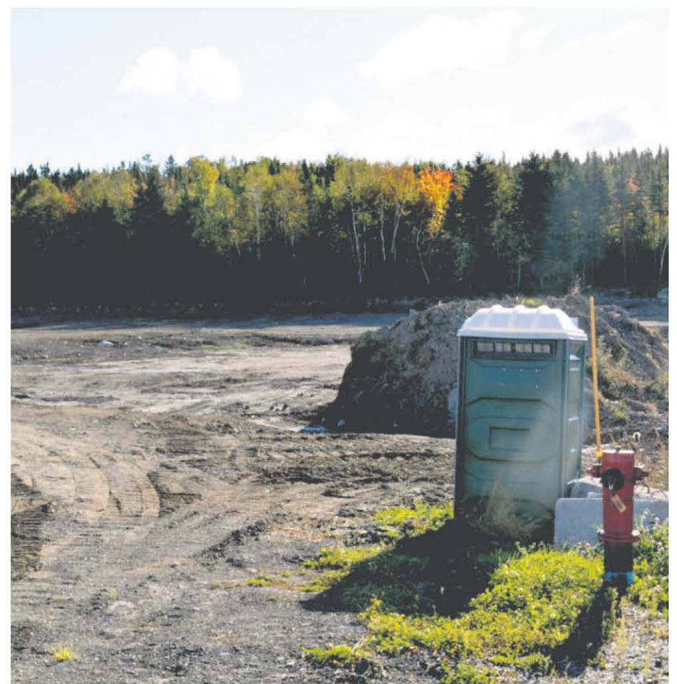
Terrain du côté sud du Parc industriel. Photo : Archives Le Placoteux.
