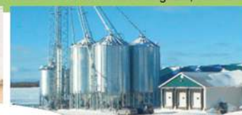
Centre de conditionnement de grains, Saint-Eloi
