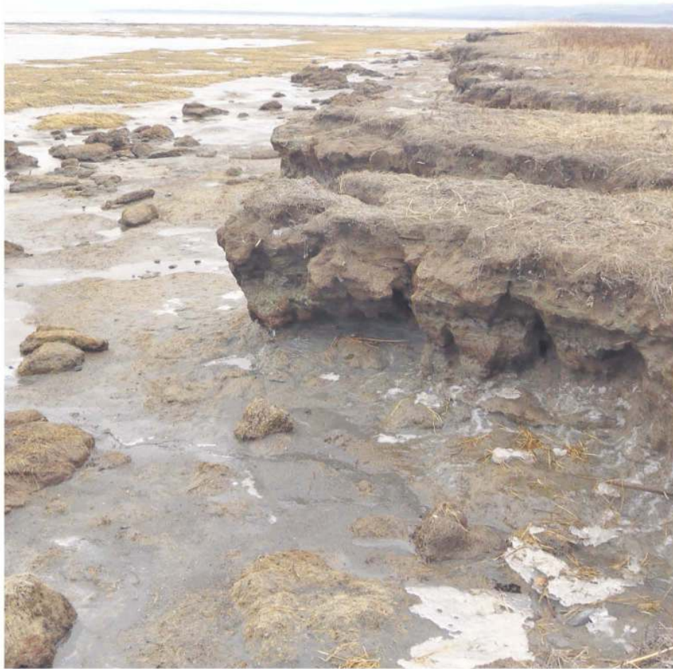
Le marais grugé par la mer, dans le secteur est de la Grande-Anse, rend vulnérable l'aboiteau à l'augmentation du niveau du fleuve. Photo : Ouranos
