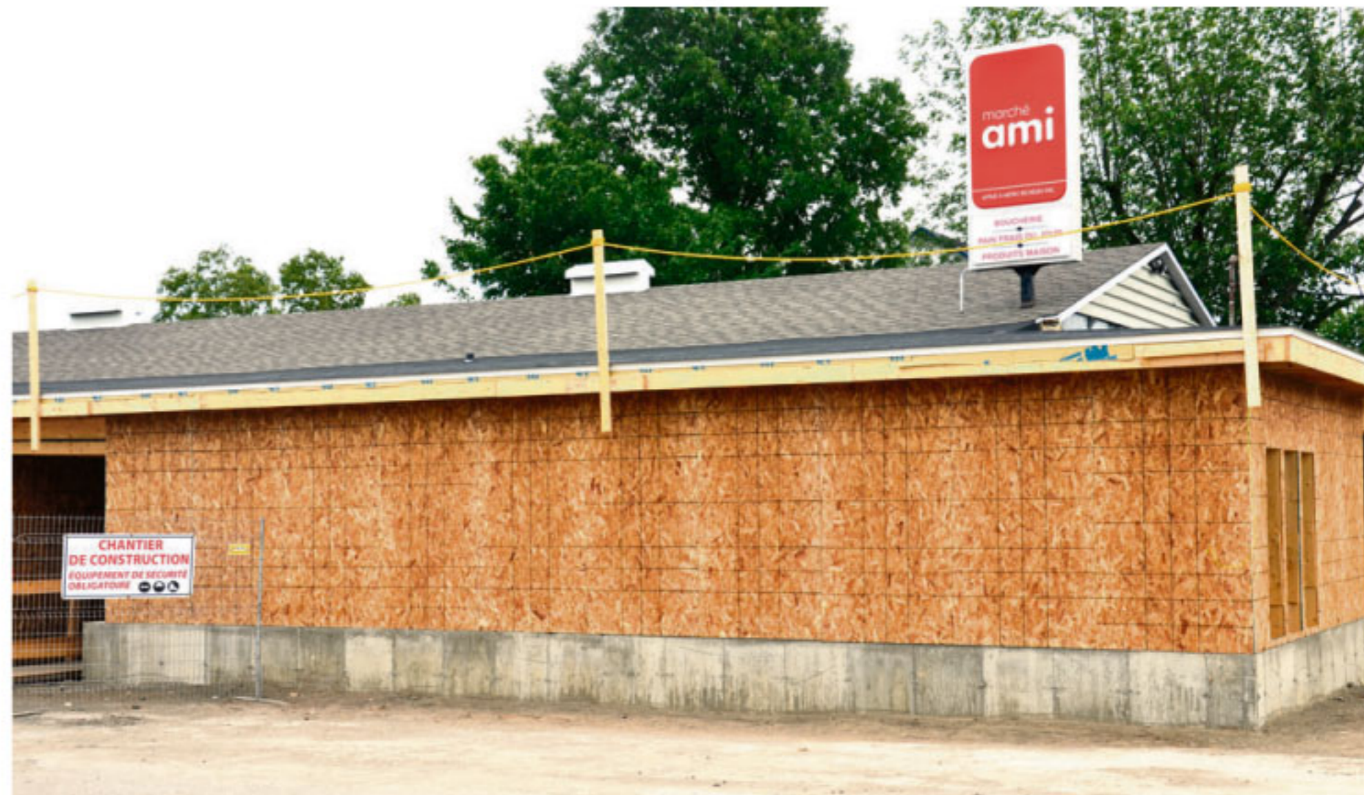
L'agrandissement est en voie d'être complété au Marché du Quartier. Photo : Maxime Paradis
