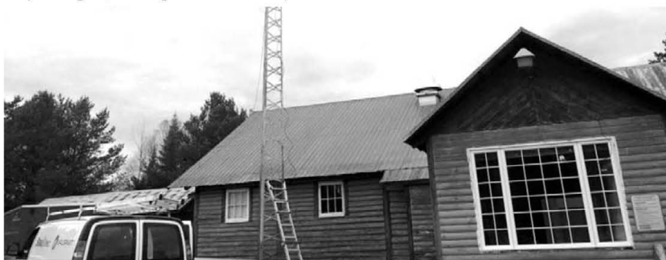
La nouvelle antenne installée au Chalet d'Ixworth. Photo tirée de Facebook.
