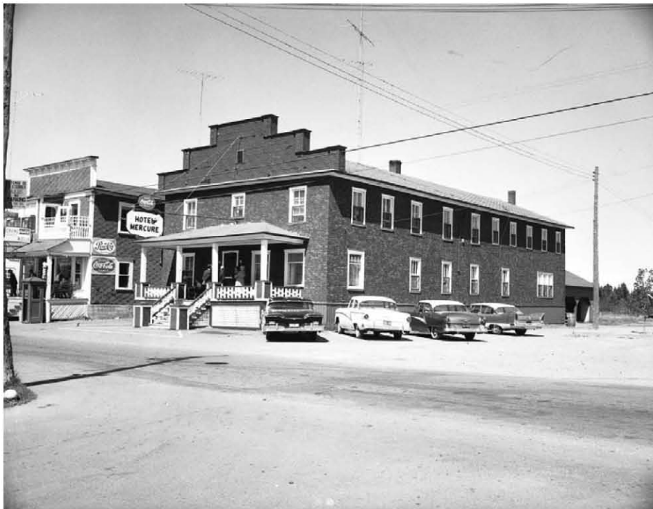
Hôtel Mercure de Tourville en 1958 (photo Raymond Boutet, Archives de la Côte-du-Sud et du Collège de Sainte-Anne).
