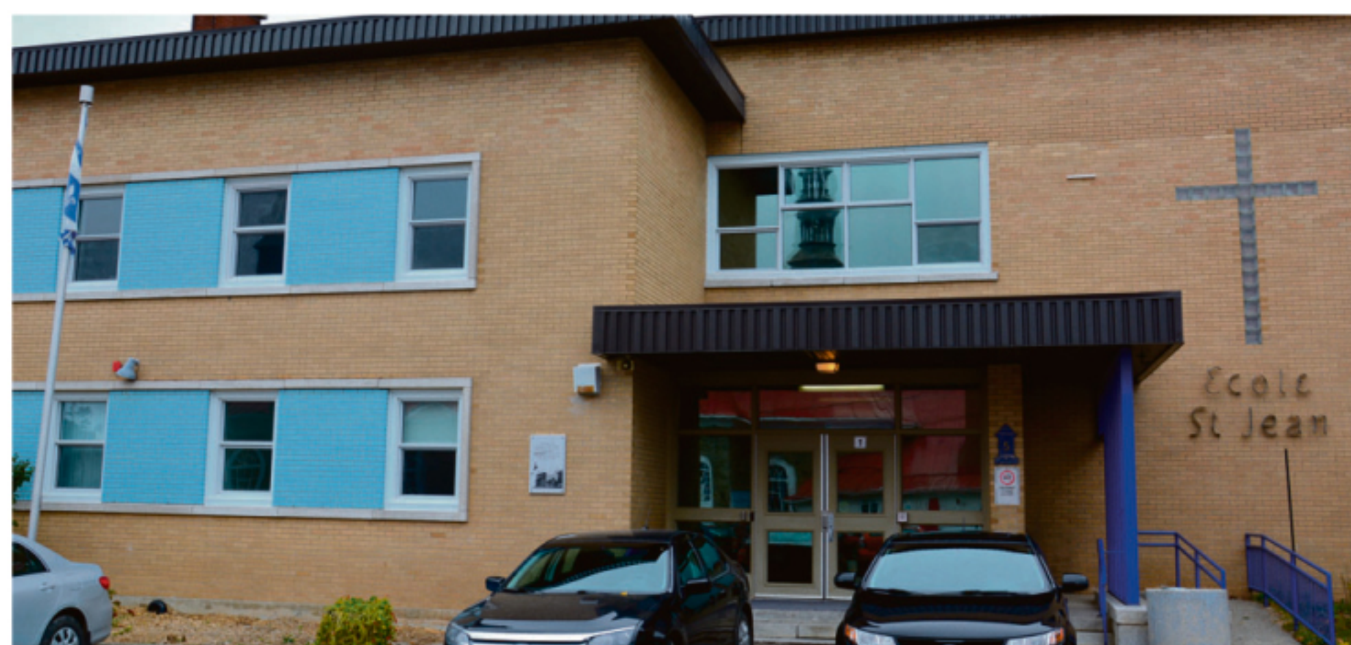
La Commission scolaire de la Côte-du-Sud terminera les travaux qui mettront un terme à un problème de plomb dans l'eau depuis trois ans à l'École Saint-Jean de Saint-Jean-Port-Joli. Photo : Maxime Paradis.
