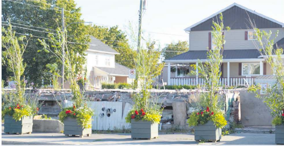
Les fondations de l'ancien Hôtel Sainte-Anne devraient disparaître à court terme.
