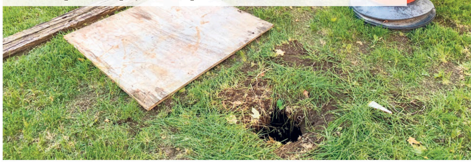
Une planche de contre-plaqué et un cône de construction avaient été installés sur le trou par des employés municipaux. Photo : Maxime Paradis
