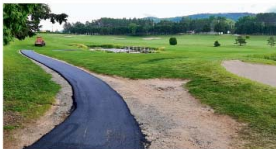
Travaux réalisés dans les derniers mois. Photo : Courtoisie Club de golf Saint-Pacôme
