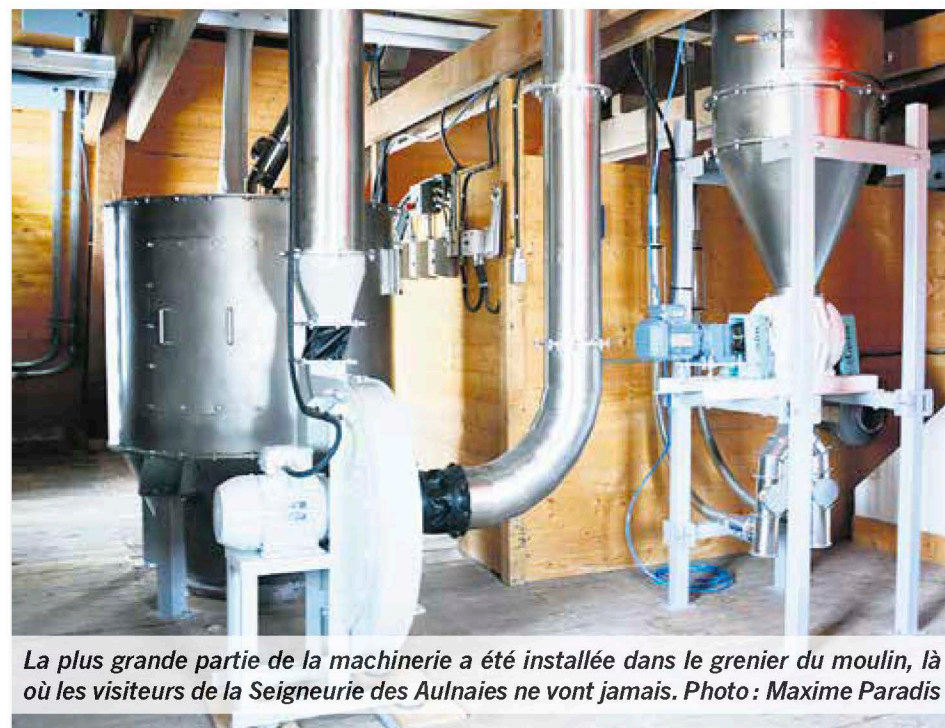
André Anglehart devant une partie de la machinerie installée dans le grenier du moulin banal. Photo : Maxime Paradis
